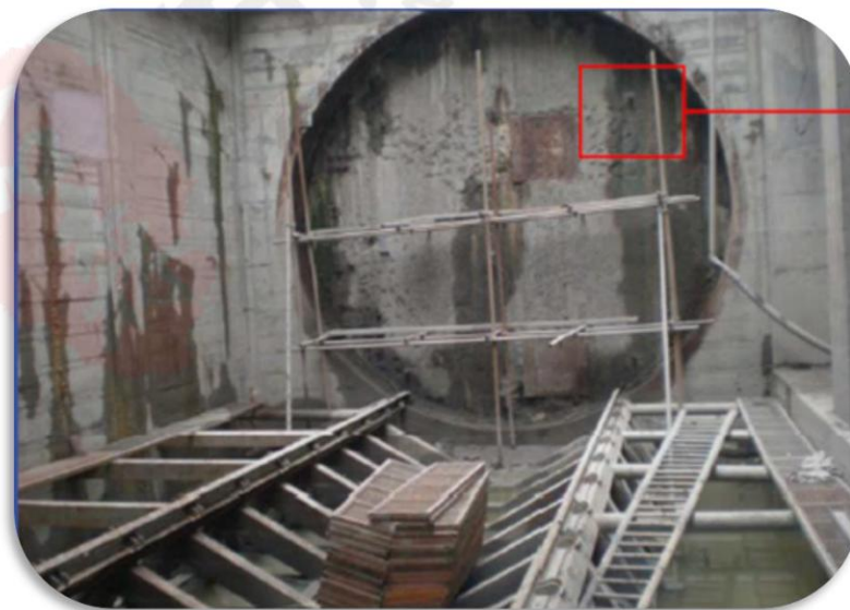
拉洞门准备打探孔
